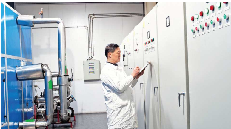
Keemiatehas - keemiatehase siseruumid on tüüpilised ISO 12944 C4 keskkond.
